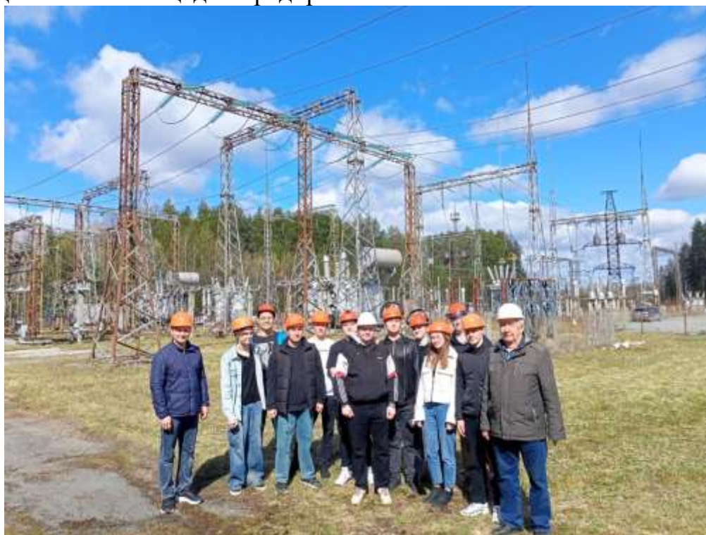
Рисунок 28 – Технический тур на подстанции «Яшма» и «Янтарь»
