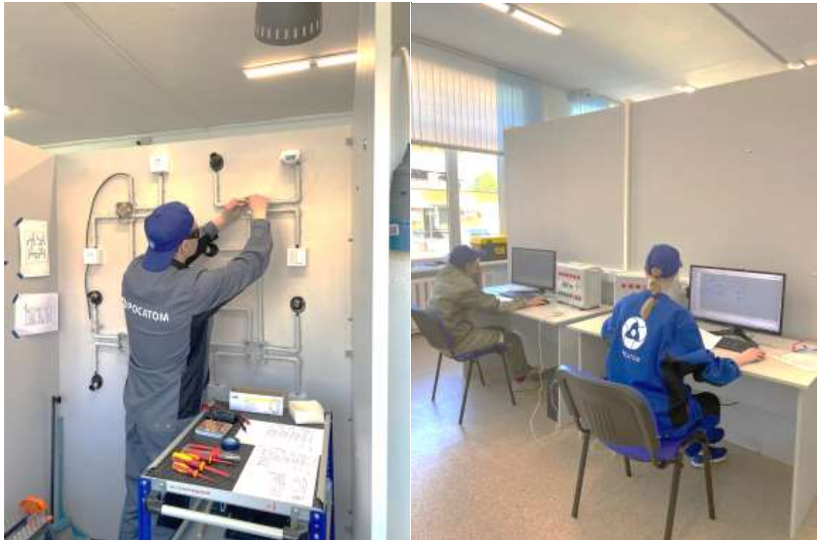
Рисунок 18. Демонстрационный экзамен по компетенции «Электромонтаж»
